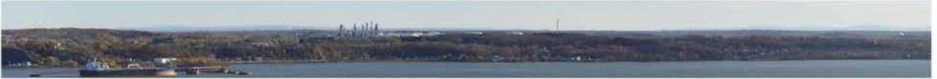
Vue du secteur Lévis à partir de la terrasse Dufferin.
