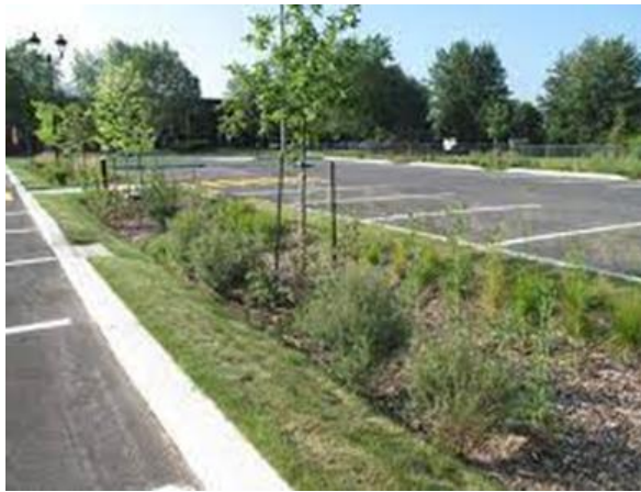
Figure 9 - Exemples d'aires de biorétention (noues végétalisées)
